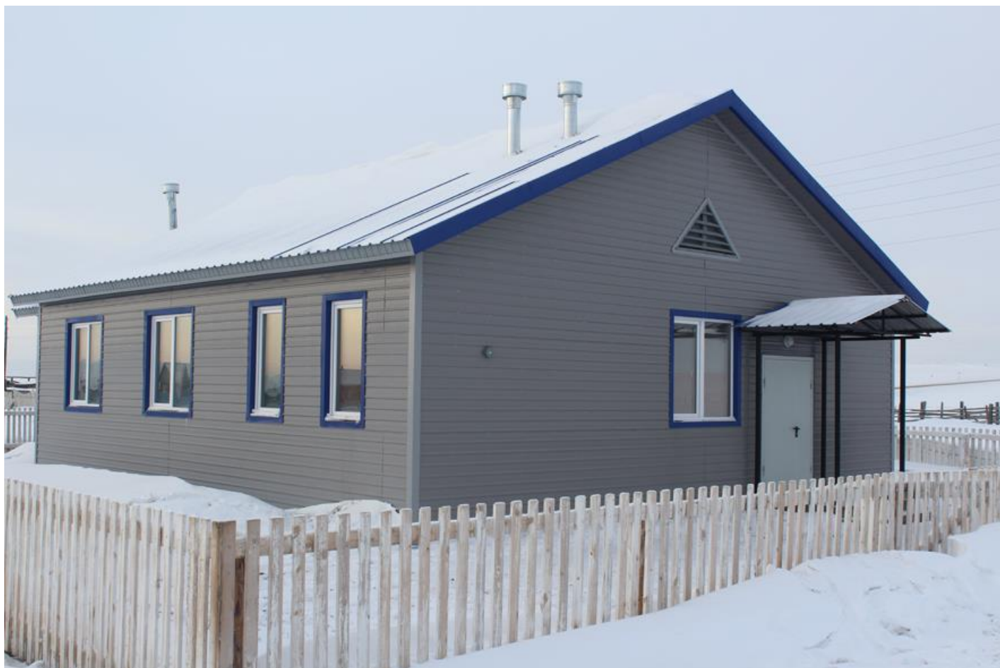
На фото: здание Галтайского ФАП, 2018 года постройки
